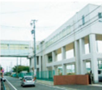
▲校舎をつなぐ「天空の通路」
